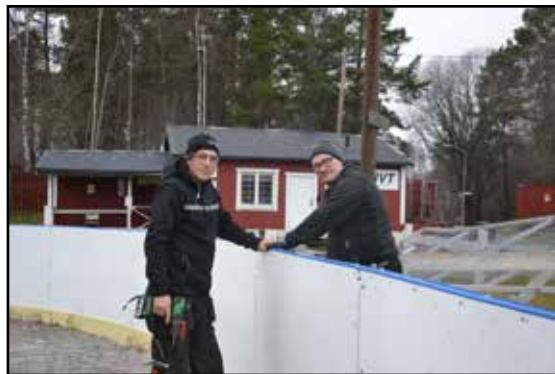
Afrim Elskani och Patrik Wass från företaget Daco Rinksystem renoverar ishockeysargen vid Lindövallen.
