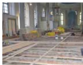
Golvet har isolerats, förberetts för bergvärme och nu ska de spontade brädorna läggas på plats
