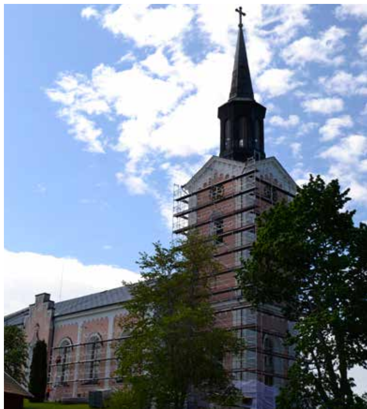
Nu fasadrenoveras Hamrånge kyrka. Arbetena skall pågå till hösten.
