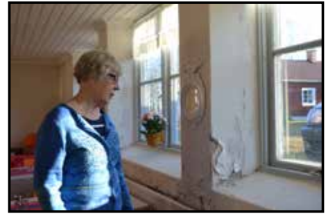
– Vi spacklar, slipar och målar gång efter gång, men så här har det blivit bara något år efteråt igen i serveringslokalen, visar Anita Nordgren
