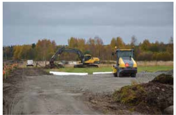
Planer och vägar anläggs intill ostkustbanan för att kunna förstärka banvallen
