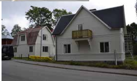
Johan Berg med sitt företag JB Core AB har köpt in fastigheterna längs Vijnvägen och nu pågår renoveringsarbetena för fullt för att iordningsställa lägenheterna.
